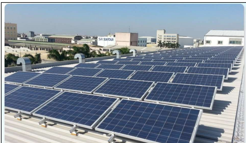
▲2014年建置福興廠頂樓建置太陽能板
