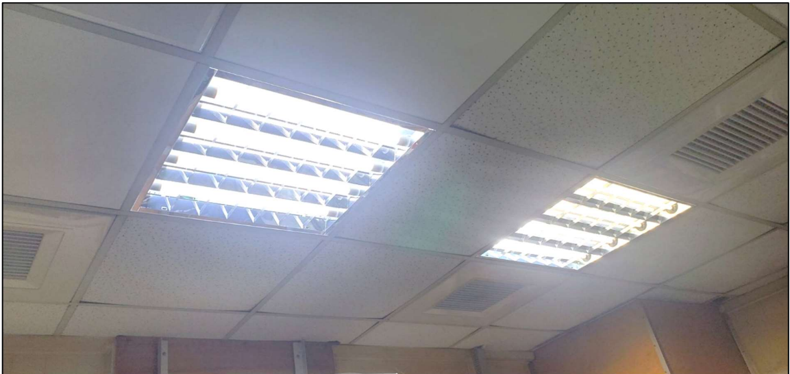
▲ LED燈更換作業
