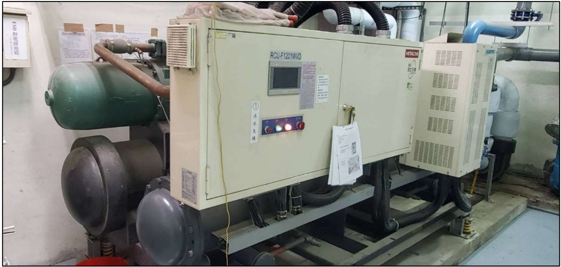
▲ 彰化福興廠120RT冰機汰換作業
